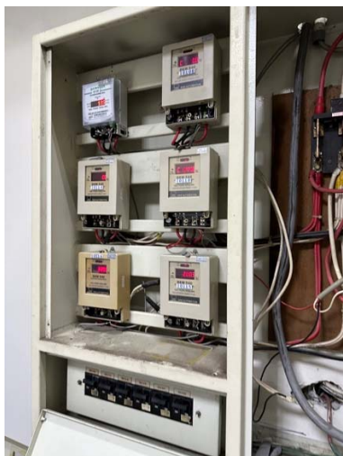
女生宿舍施工前
