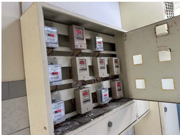
男生宿舍施工前
