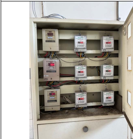
女生宿舍施工前
